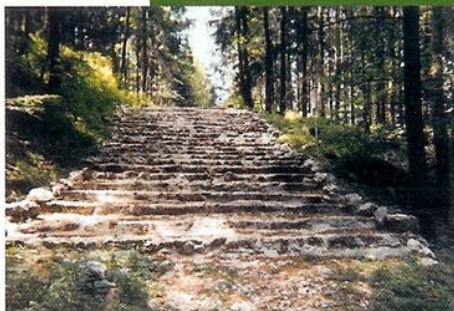
Un tronçon du Löwengang, état actuel (après réhabilitation en 1999)
